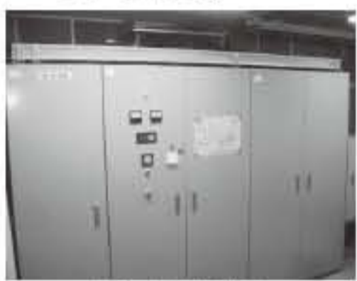
据え付け作業中
