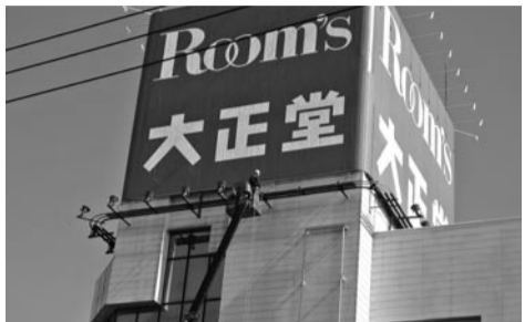
広告塔照明のLED化工事
