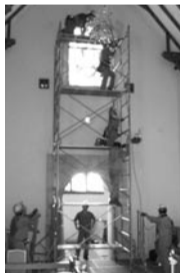
LEDの交換工事
