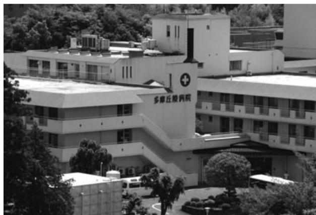
正面入口から臨む多摩丘陵病院病棟
