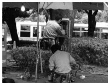
電気工事するホンマ電機社員
