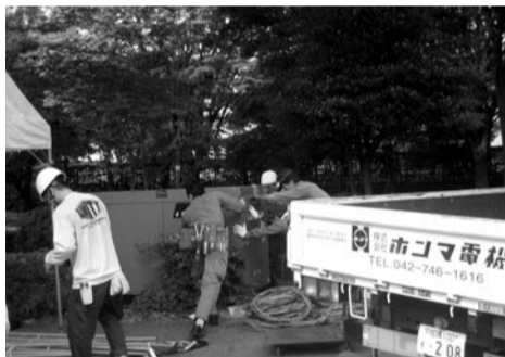
可搬型発電機の据え付中
