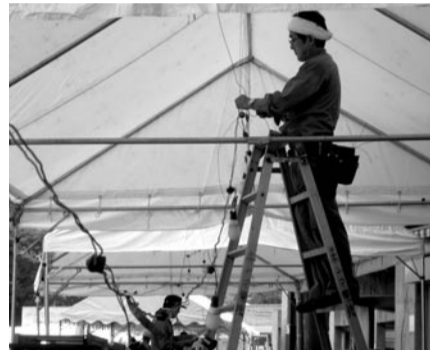
もんじえ祭りの配線作業中
