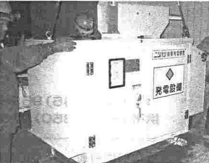
七階屋上に据付が完了したキュービクル
