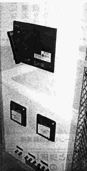
設置した高圧受電盤
