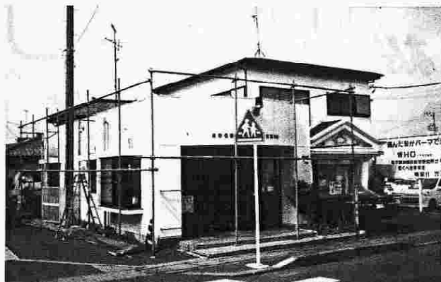
外壁塗装工事
