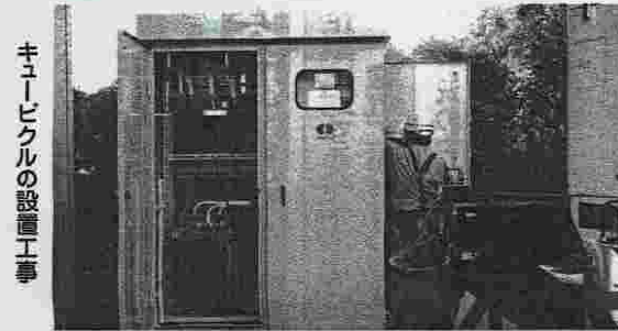
キュービクルの設置工事
