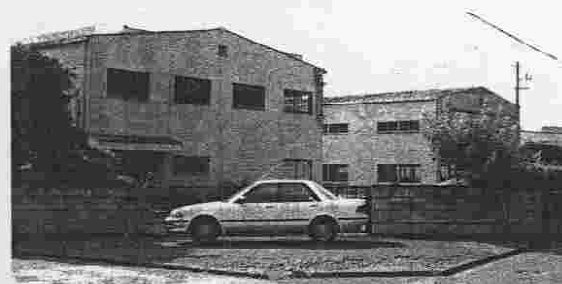
改修予定の建物と引込み
