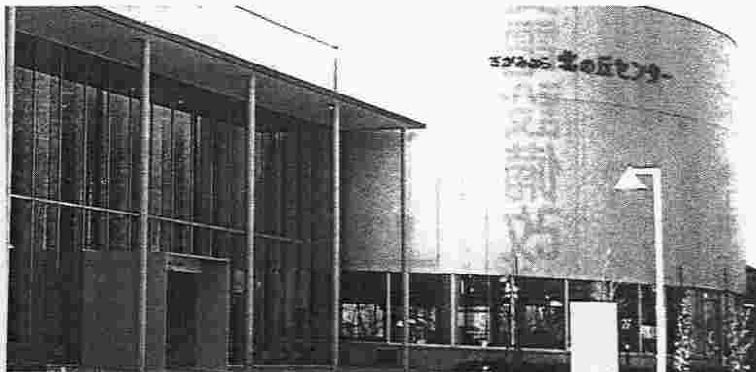
さがみはら北の丘センターのエントランス
